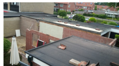
Nach Abriss der Garage
