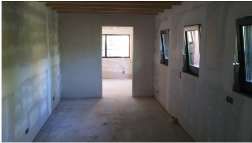
Alle Wände verputzt und der Boden eingeebnet
